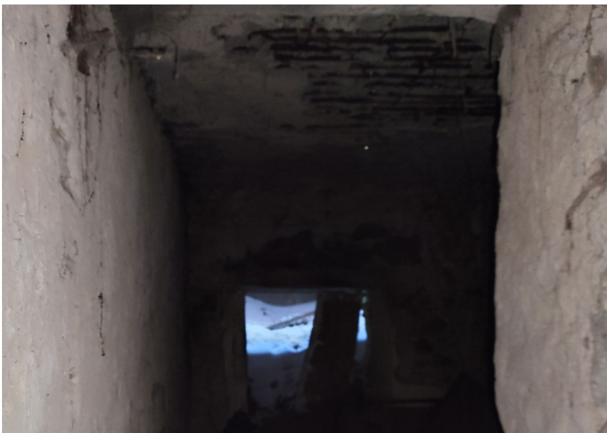
Фото. Б. 6 Разрушение защитного слоя бетона плит перекрытий.
