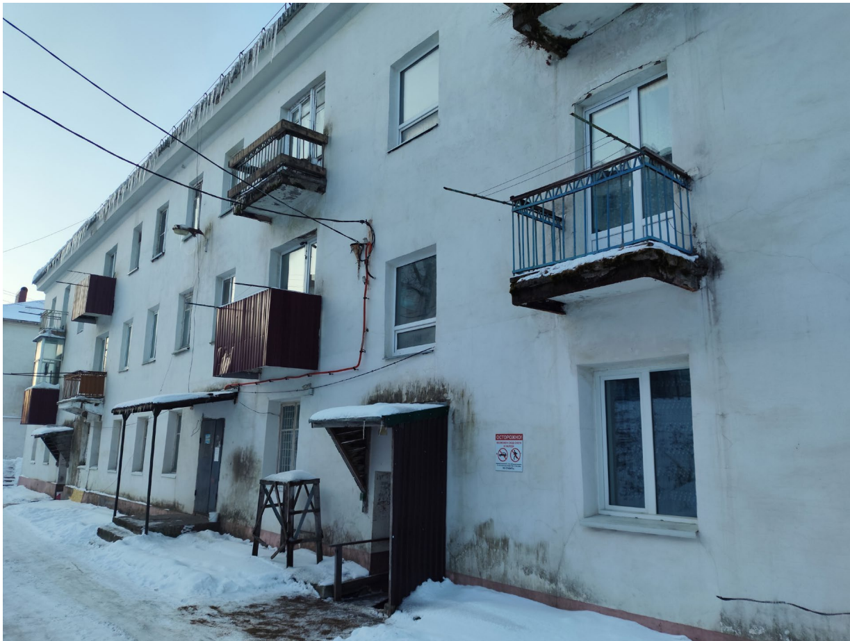
Фото. Б. 8 Водосточная система отсутствует.
